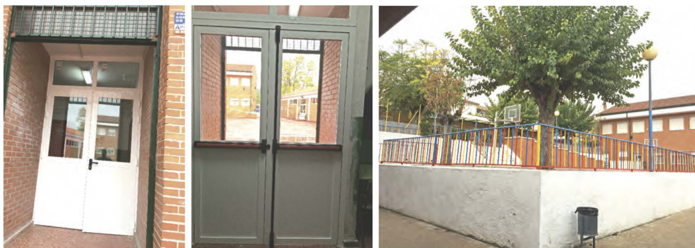
Puerta de seguridad. Colegio Miguel de Cervantes
