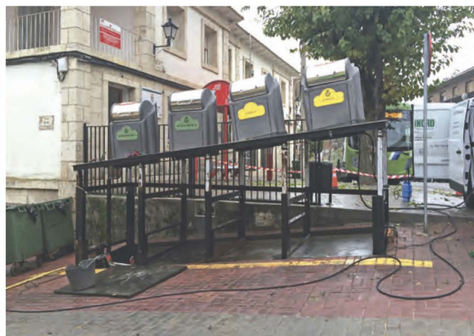
Limpieza contenedores soterrados C/ Miguel de Cervantes
